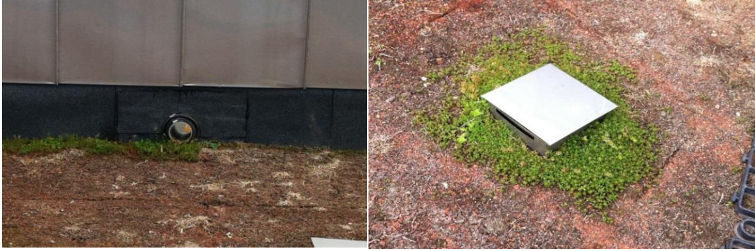
Figur 42 Projektering av brunnar och genomföringar är viktiga för att undvika risk för läckage. Fuktsäkerhetsprojektering skall dokumentera fuktsäkra lösningar. Foto: Eva Sikander
