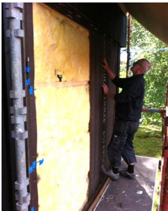
Figur 4. Återuppbyggnad av befintlig vägg efter inbyggnad av sensorer.
