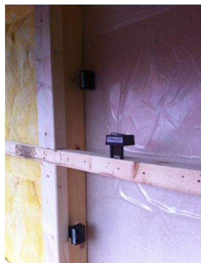
Figur 2. Demontering och instrumentering av befintlig vägg.
