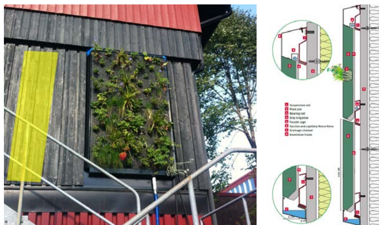
Figur 5. Modulerad grön vägg, RISE Borås.
