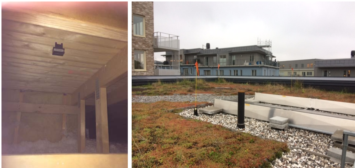
Figur 4. Exempel på trådlös sensor använd vid Stora Sjöfallet för avläsning av omgivande lufttemperatur och relativ fuktighet samt fuktkvot i råspont under takyta (tv) och takets utseende vid mätperiodens avslutande september 2017 (th).
